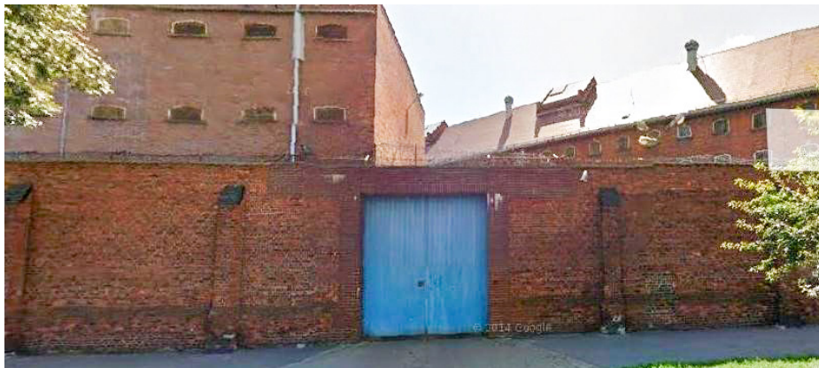
Więzienie przy ul. Kleczkowskiej we Wrocławiu
